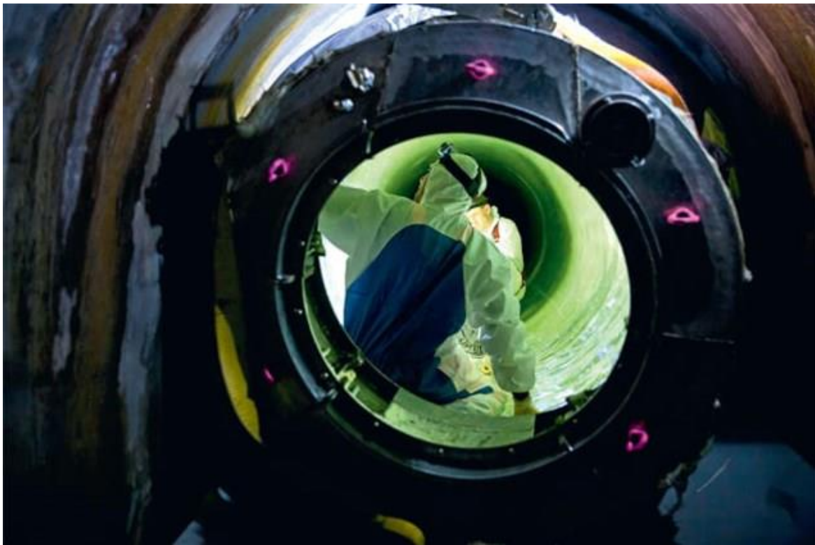
Ausbau der Leichtbaupacker
